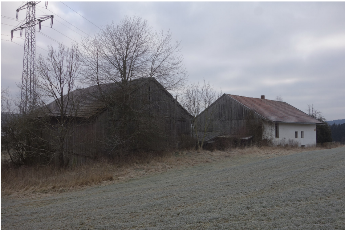
Abb. 3: Scheune und Wohnhaus von Westen
