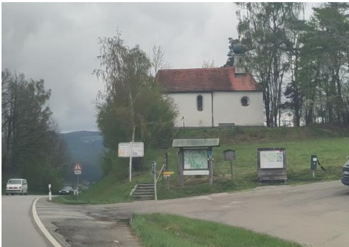
Abbildung 14: Denkmal „Kirche St. Anton“ auf dem Pfahlriegel mit Einfahrtsbereich und Parkplatz entlang der Staatsstraße; Blickrichtung nach Nordosten, 2024 (Quelle: brunner architekten)
